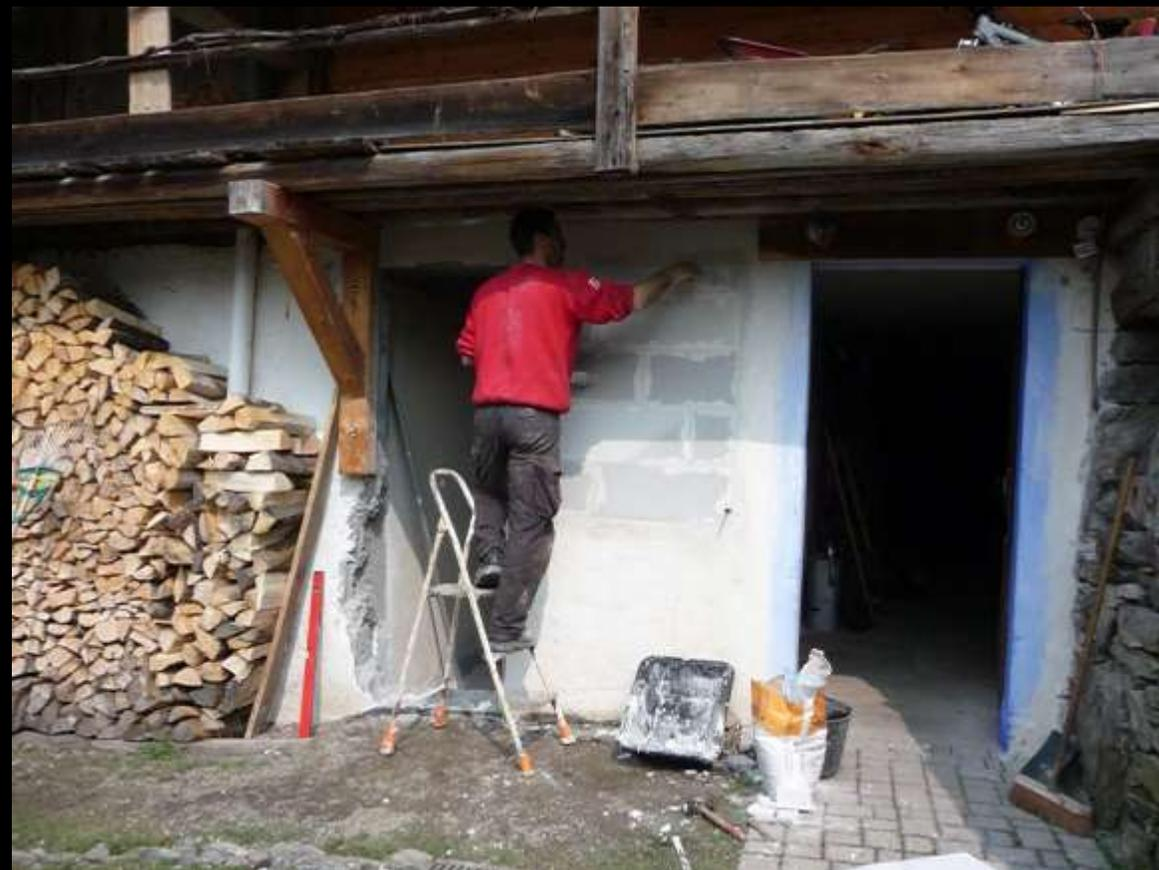
Les blocs de béton cellulaire sont utilisés pour leurs capacités isolantes et facilité de mise en œuvre.
